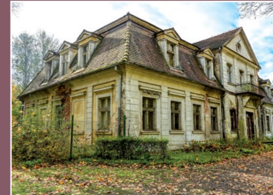
Dawny dworek w Białej Ehemaliges Gutshaus in Behle
