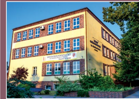
Modernistyczny gmach LO w Trzciance Modernistisches Gebäude des Lyzeums in Schönlanke
