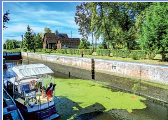
Na noteckiej śluzie w Romanowie Auf der Netze - Schleuse in Romanshof
